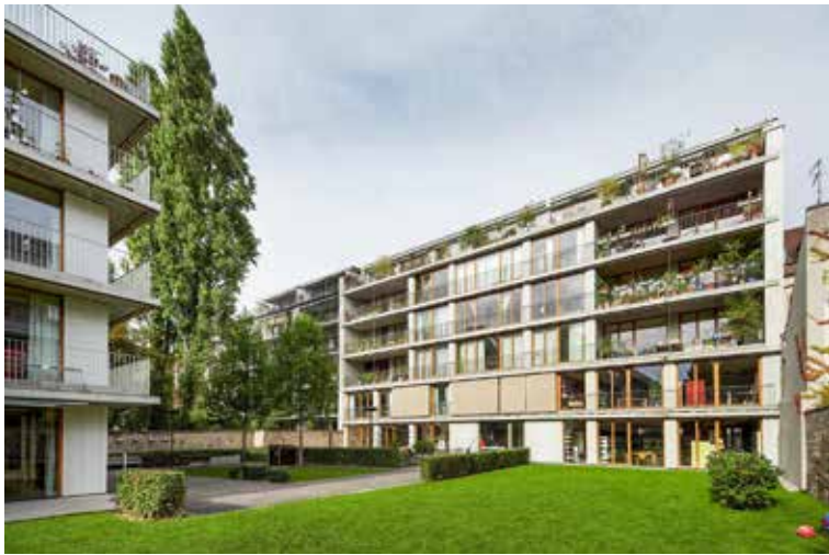
An der Elsässer- und der Fatiostrasse erstellte die Stiftung Habitat 2006 zwei Neubauten, die unterirdisch über einen gemeinsamen Garten verbunden sind. Das quartier- und sozialverträgliche Projekt richtet sich vor allem an Familien mit Kindern und Jugendlichen. Deren Mitwirkung ist ausdrücklich erwünscht.
